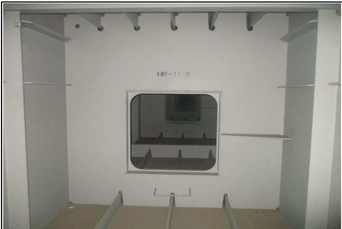
강박스 내부 전경
